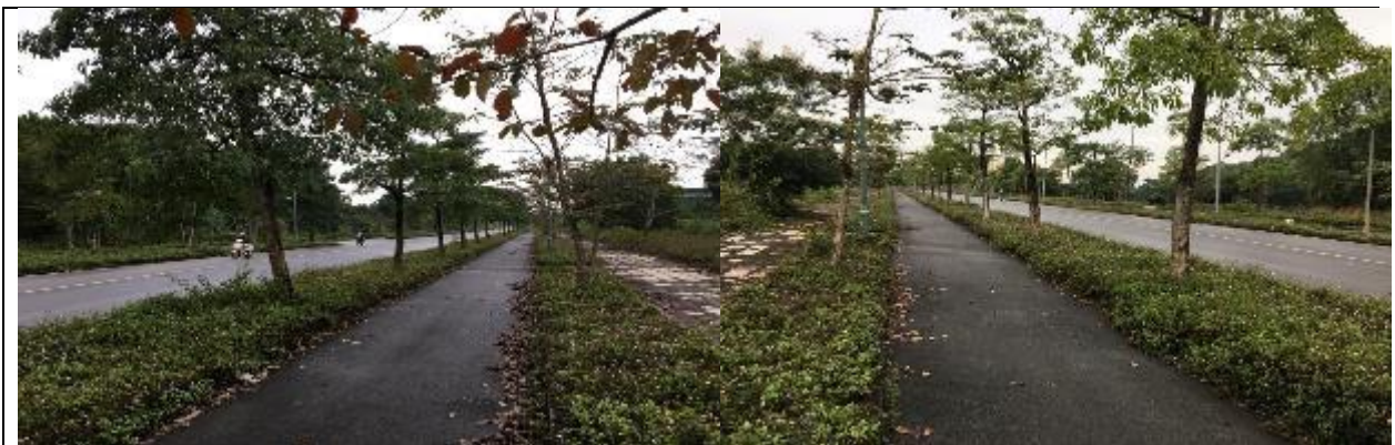
Hệ thống cống thoát nước mưa được xây dựng chìm ở phần vỉa hè
